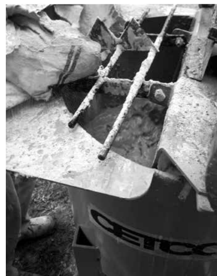
Mieszanie zaprawy BENTOGROUT® mieszadłem firmy CETCO
