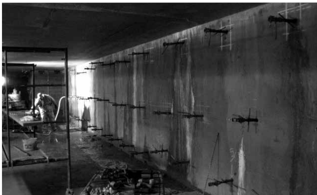
INIEKCJA ZAPRAWY NA POWIERZCHNIACH WEWNĘTRZNYCH: Zaprawa BENTOGROUT® stosowana wewnątrz budynku bez konieczności odkopywania konstrukcji
